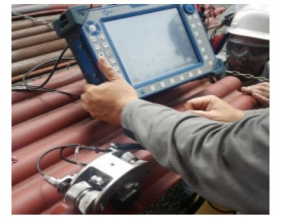
Badanie korozji ścian szczelnych kotła
