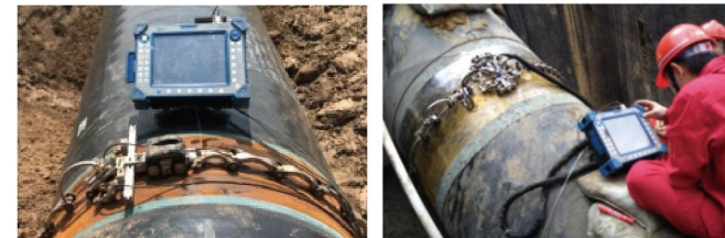
Badanie spoin obwodowych rurociągów naftowych i gazowych
